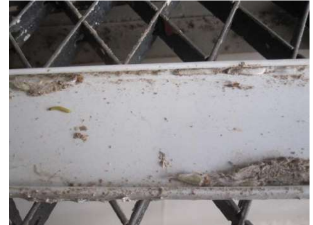
Гарна схованка під накриттям для електрокабелю
